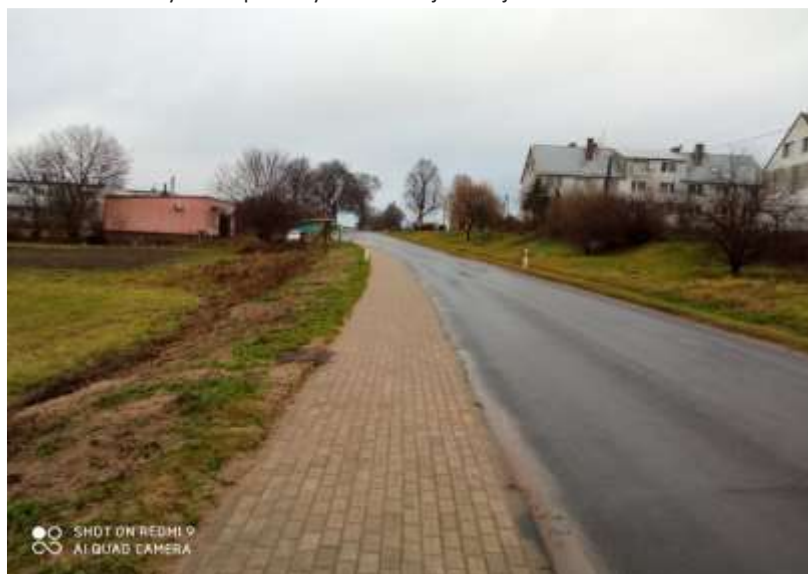
Remont chodnika w miejscowości Sławka Wielka
