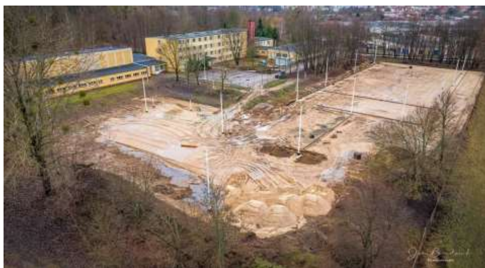
Prace przy realizacji projektu Zagospodarowanie terenu sportowego przy Zespole Szkół Zawodowych i Ogólnokształcących w Nidzicy
