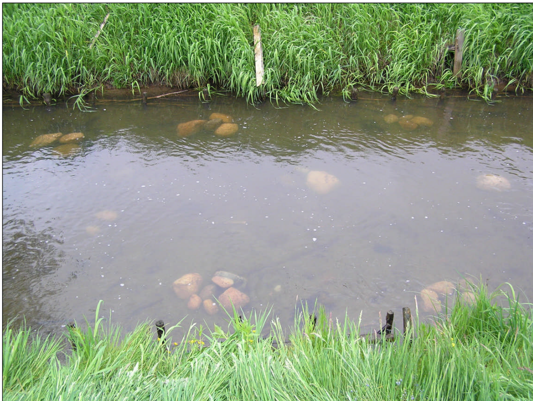
Ryc. 6. Koryto rzeki Nidy po urozmaiceniu struktury dna przy użyciu głazów i otoczaków (fot. A. Skrzypczak).
