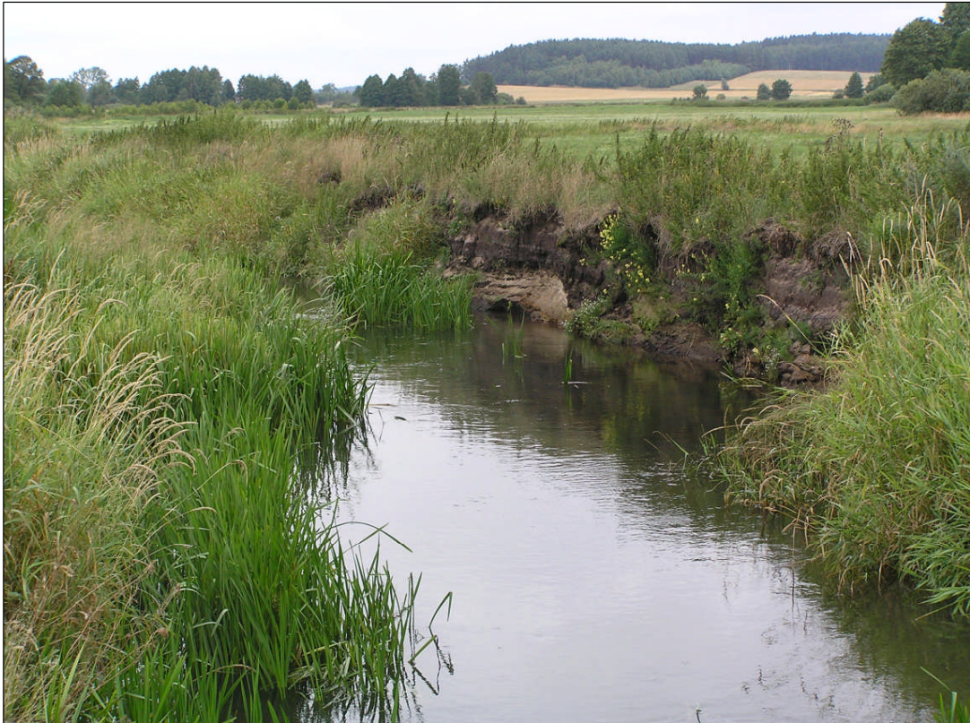
Ryc. 18. Punkt X15 oceny hydromorfologicznej – czwarte zakole maendru rzeki z widoczną erozją prawej skarpy (fot. A. Skrzypczak).
