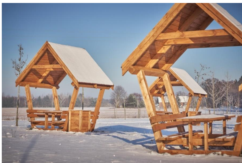
„Rozwój ogólnodostępnej infrastruktury turystycznej, rekreacyjnej i kulturalnej poprzez montaż tablic informacyjnych oraz wykonanie wiat rekreacyjnych wraz z zagospodarowaniem terenu w Powiecie Nidzickim”
