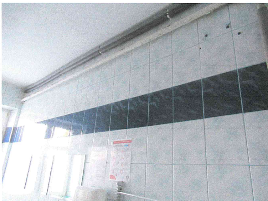
Fot. nr 10. Sanitariat w budynku Internatu
