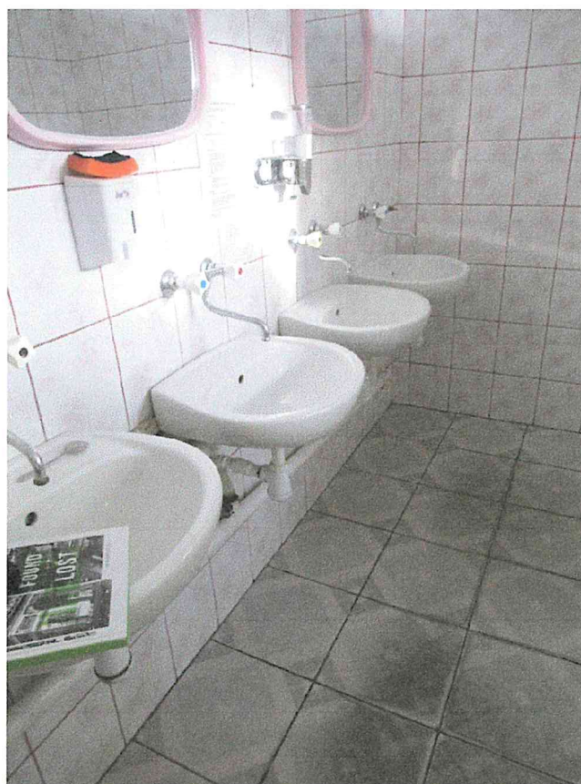
Fot. nr 8. Sanitariat dla dziewcząt na piętrze budynku szkolnego
