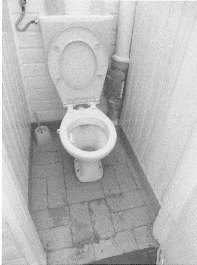
Fot. nr 5. Sanitariat dla chłopców w parterze budynku szkolnego
