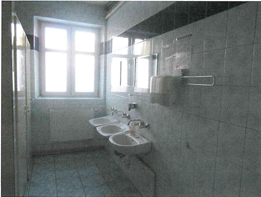
Fot. nr 11. Sanitariat w budynku Internatu
