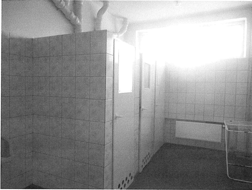
Fot. nr 1. Sanitariat dla chłopców w parterze budynku szkolnego
