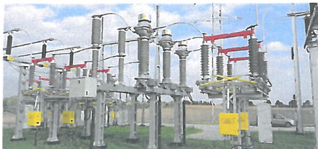
R-110 kV. Pole rozdzielcze linii 110 kV GPZ Działdowo
