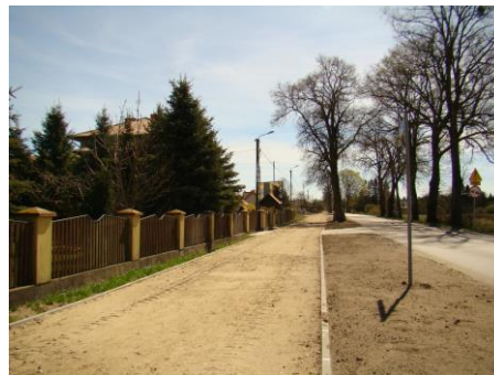
Budowa ciągu pieszo rowerowego ul. Olsztyńska
