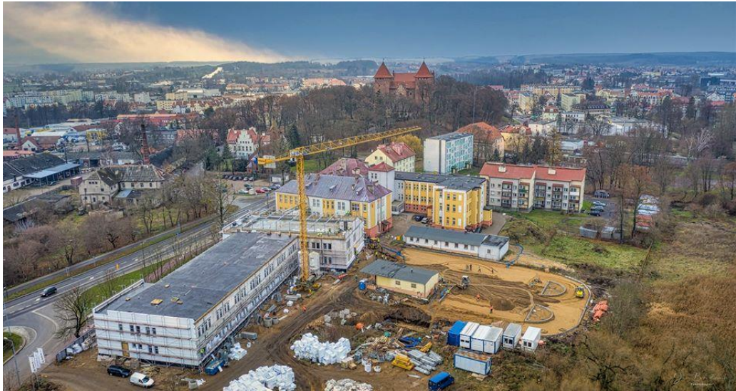
Rozbudowa budynku ZOZ
